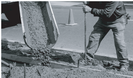
Figura 1: Despejo de concreto em obra.
