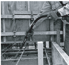
Figura 2: Utilização do vibrador de concreto em uma laje.
